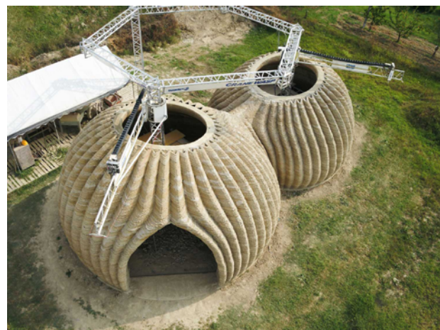
■ realizovaný 3D tlačený dom na báze hliny – TECLA HOUSE zdroj: 3dwasp.com / realised 3D printed house of clay – TECLA HOUSE source: 3dwasp.com
