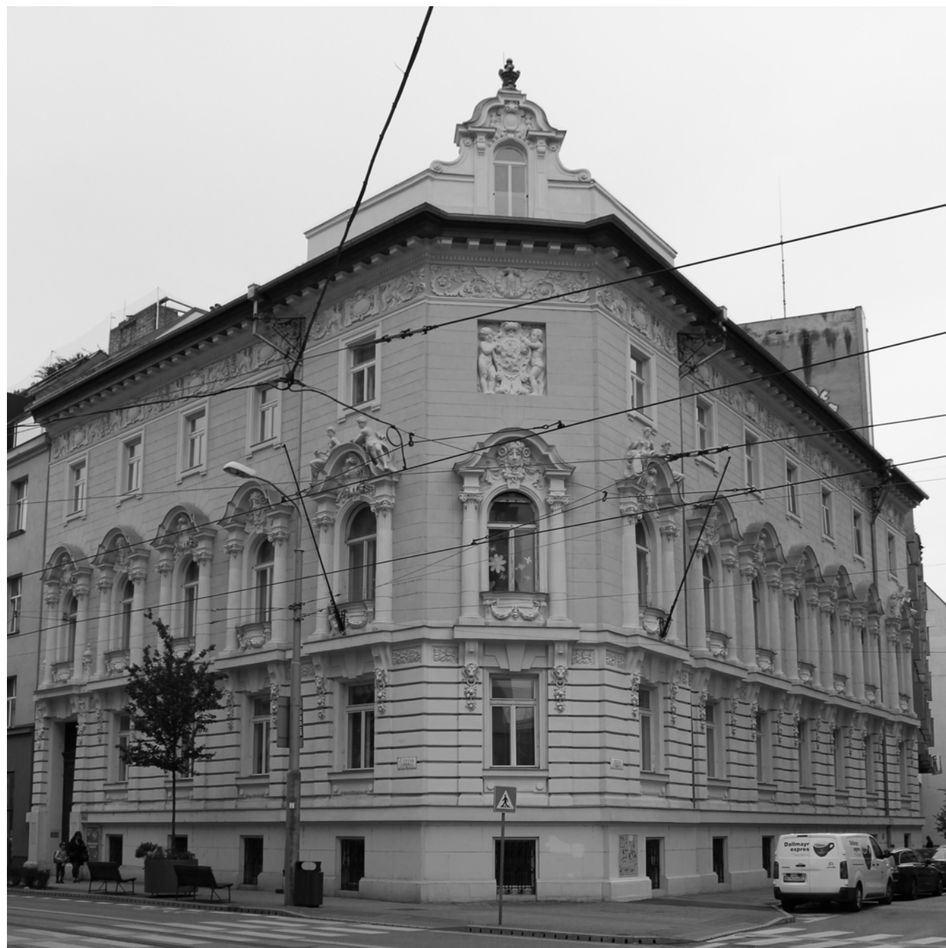
■ 01 Budova filiálky Rakúsko-uhorskej banky v Bratislave (József Hubert, 1901-1902, nadstavba M. Blecha, 1921-1922) zdroj: fotoarchív autorky / Branch office of the Austro-Hungarian Bank in Bratislava (József Hubert, 1901-1902, extension M. Blecha, 1921-1922) source: photo archive of the author
