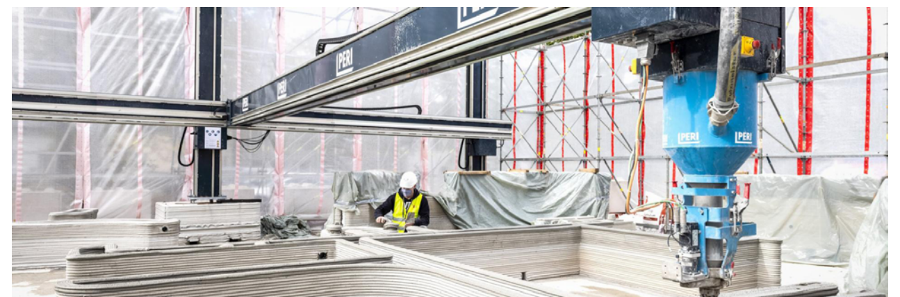
▪ rámová tlačiareň tlačíaca dom in situ na báze cementového kompozitu zdroj: heidelbergmaterials.com / gantry printer printing house based on cement composite, in situ source: heidelbergmaterials.com
