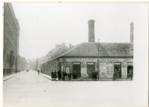
■ Pôvodná zástavba Lazaretskej ulice, Bratislava (1927). © Archív mesta Bratislava / The former urban structure of Lazaretská Street (1927). © Bratislava City Archives
