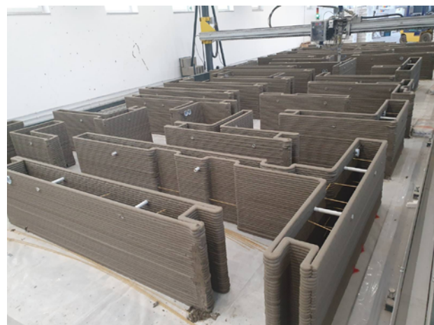
■ rámová tlačiareň tlačíaca prefabrikáty domu vo výrobnej hale prvej slovenskej firmy zaoberajúcej sa stavebnou 3D tlačou zdroj: 3dcpro.sk / gantry 3D printer printing house prefabs in the production hall of the first Slovak company dealing with construction 3D printing source: 3dcpro.sk
