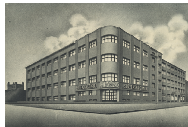
■ Slovenská grafia, Lazaretská, Bratislava (1935 – 1937). Projekt a realizácia R. Frič. © Archív mesta Bratislava / Slovak Graph, Lazaretská Street, Bratislava (1935 – 1937). Project and realisation R. Frič. © Bratislava City Archives
