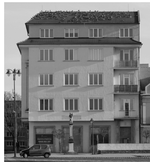
■ 05 Budova filiálky Americko-slovenskej banky v Topoľčanoch (Ing. Frič?, po 1930) zdroj: fotoarchív autorky / Branch office of the Americko-slovenská banka in Topoľčany (Ing. Frič?, after 1930) source: photo archive of the author
