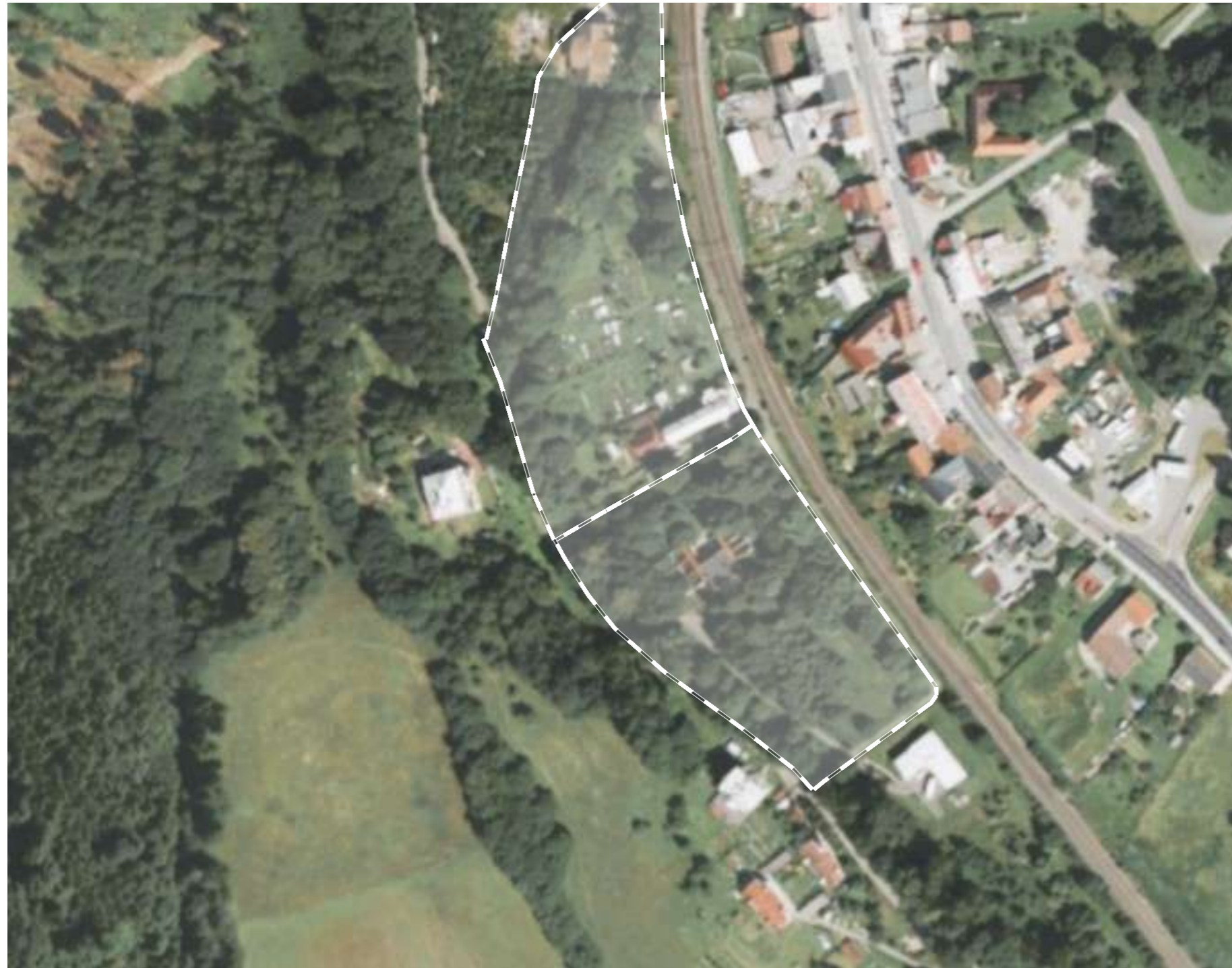
JUŽNÁ ČASŤ B , STAV PO ZBÚRANÍ OBJEKTOV
