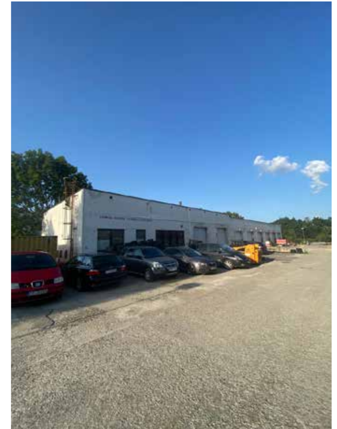
zanedbaná nekvalitná stavba - dnes využívaná ako autoservis
