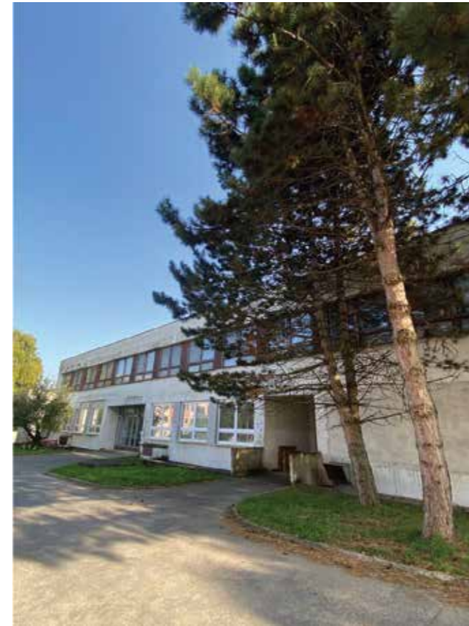
zanedbaná nekvalitná stavba - bývalá jedáleň
