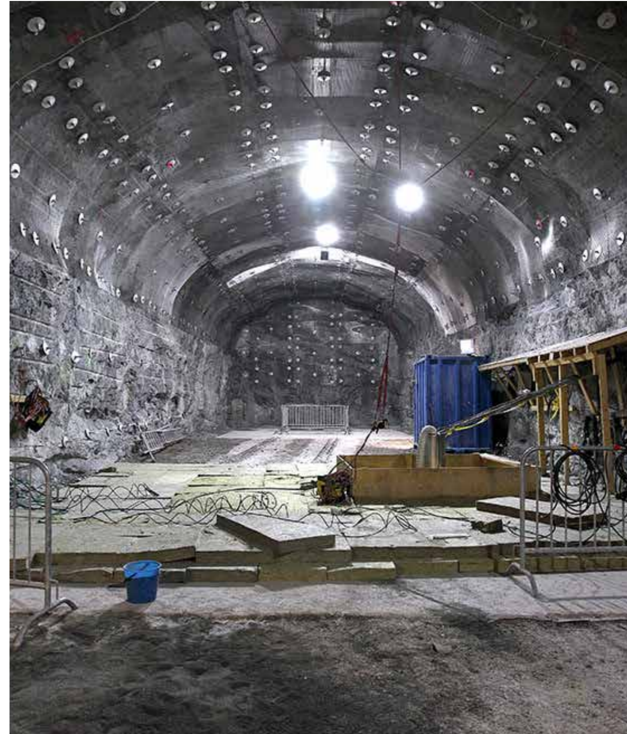
o15_ Výstavba úložiska Onkalo
