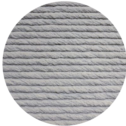
Fasáda vnútorných objektov cementová 3D tlač
