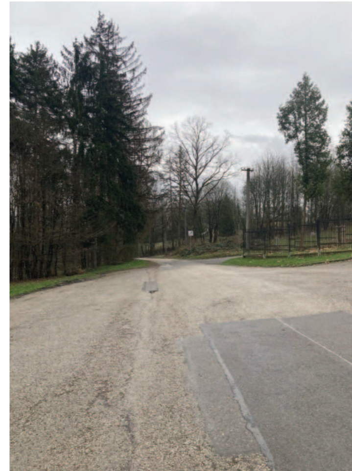
ALTERNATÍVNA PRÍSTUPOVÁ KOMUNIKÁCIA (NA MALÝ DIEL)
